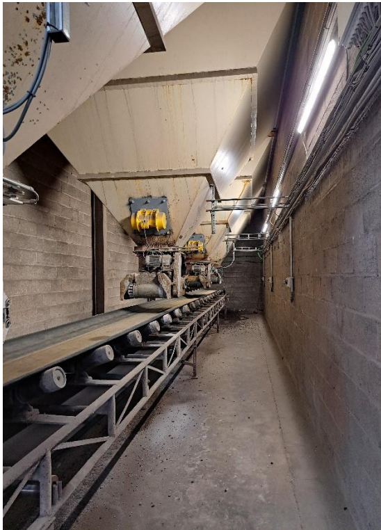
Breekinstallatie voor beton en asfalt.
